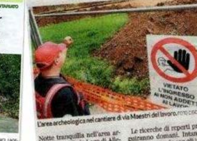
L'area archeologica nel cantiere di via Maestri del lavoro.
